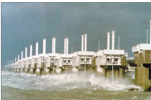
La "huitième merveille du monde" : les écluses dans l'estuaire de l'Escaut, ouvertes par beau temps, fermées pour cause de tempête.
